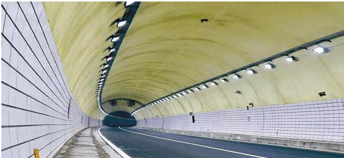
基于 LED 的隧道灯最明显的优势是它们的寿命长和效率高：在典型的隧道照明应用中，高品质的 LED 照明系统能够提供大于 110 LM/W。
